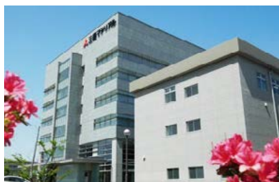
MTEC Saitama (Centro Técnico do Leste do Japão)
